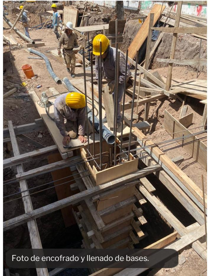
Foto de encofrado y llenado de bases.
