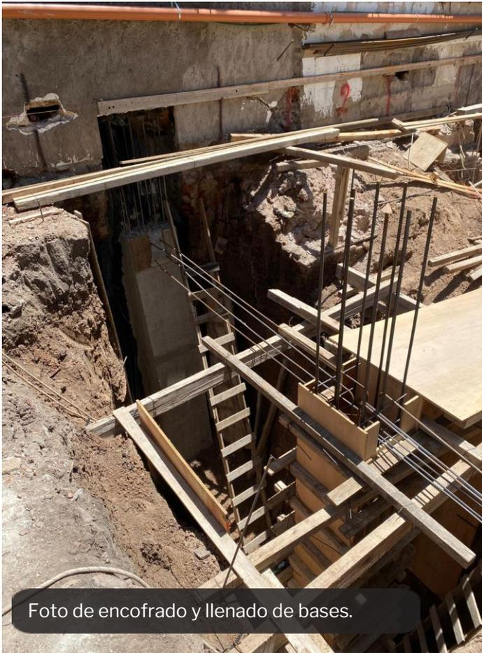
Foto de encofrado y llenado de bases.
