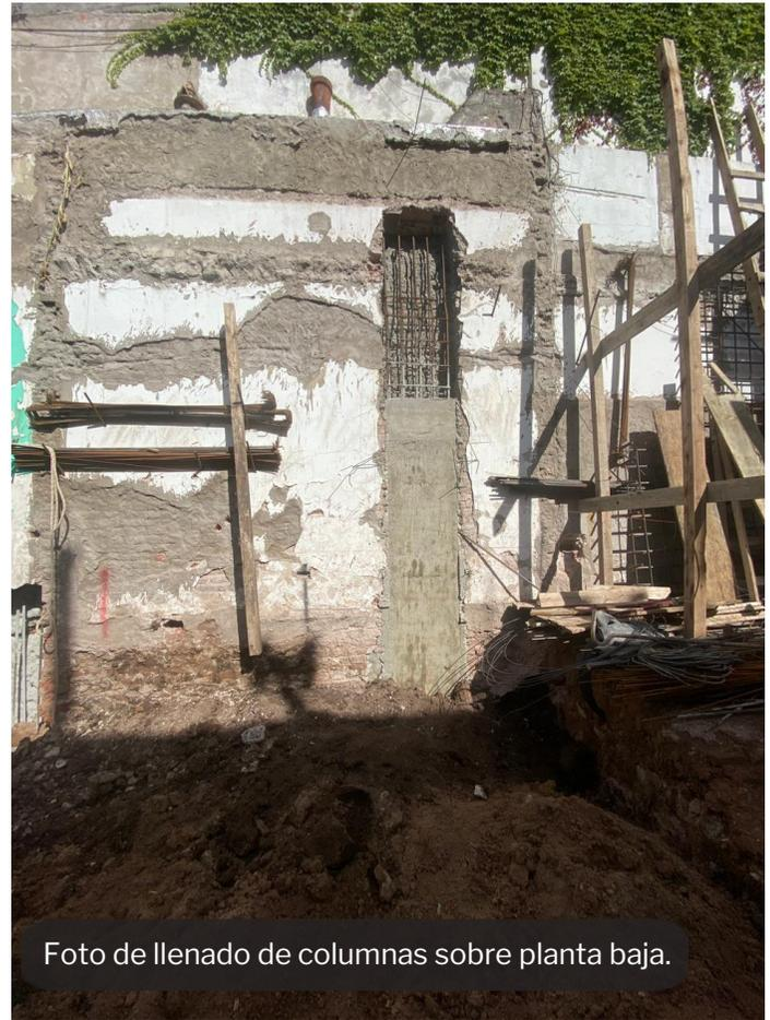
Foto de llenado de columnas sobre planta baja.
